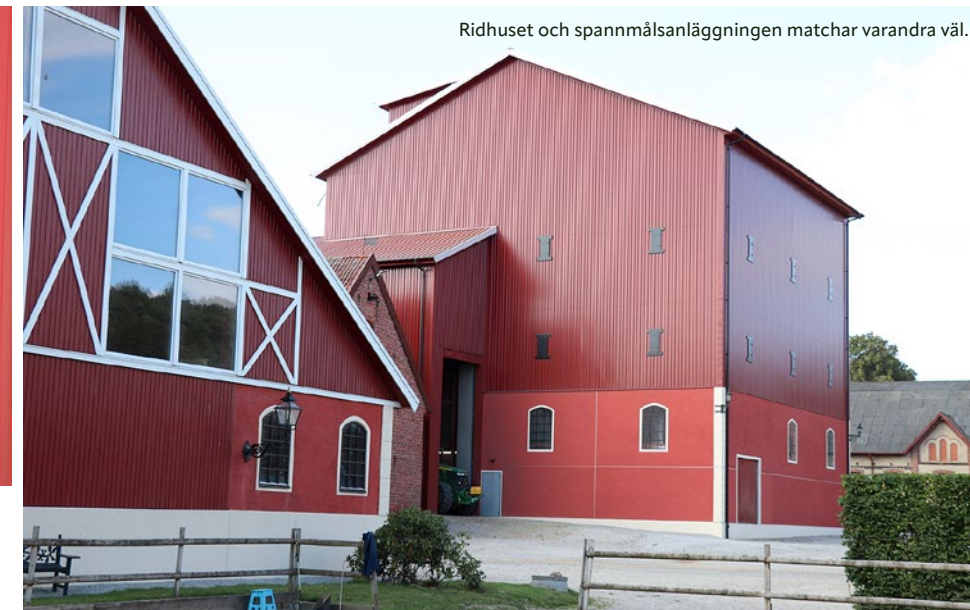
Blindluckor i plåt pryder den höga byggnaden.
